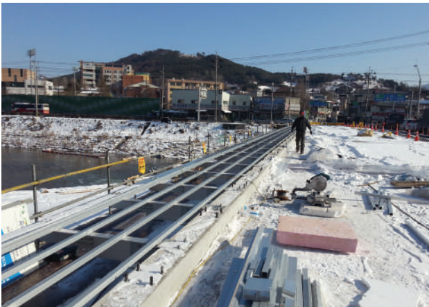
3. 하지 작업 완료
