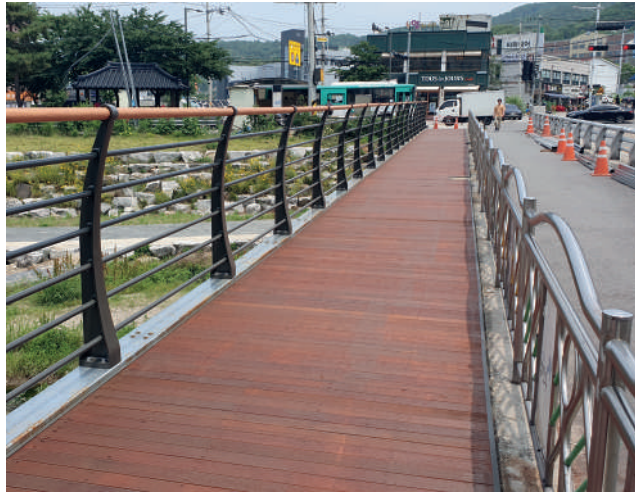
●인도교 설치 후(인도 확보를 통한 안전 보행)
