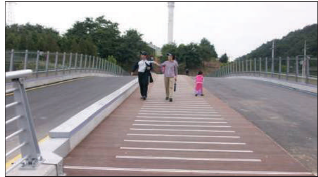
■ 난지공원 평화,중앙 브릿지 데크 설치공사
