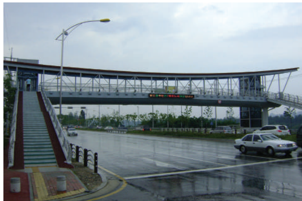
■ 하남시 조정호간육교 경관 캐노피 설치공사
