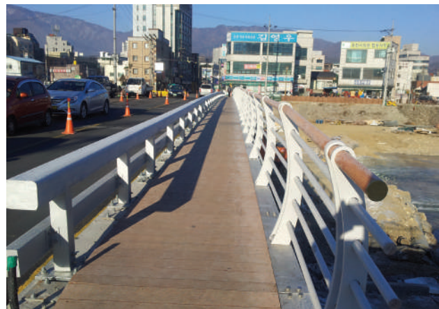
6. 시공 완료 후 개통
