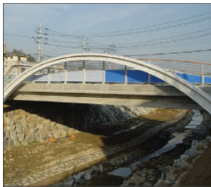
파주시 분수천 개수공사
