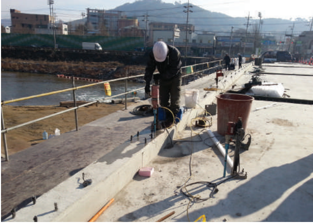
1. 코아 천공 작업
