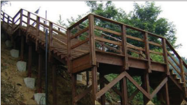
■ 난지공원 목재 계단 설치공사
