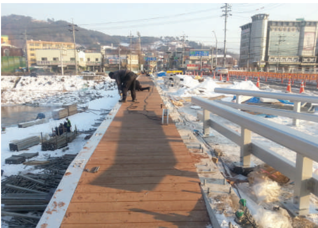
5. 난간 및 방호책 시공
