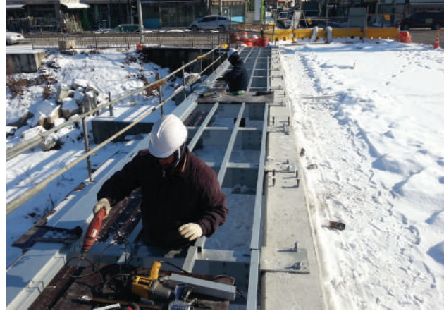
2. 브라켓 및 하지 장선 거치작업
