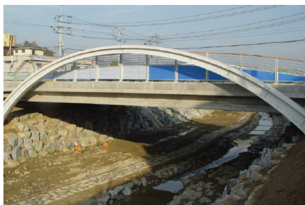
■ 파주 분수천 교량 조형물 설치공사
