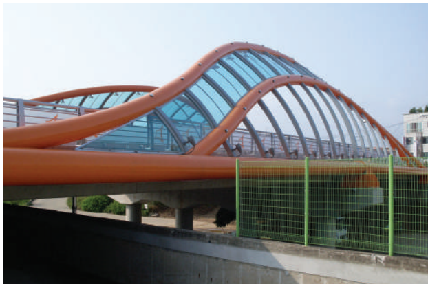
■ 화성시 발안천교 조형물 설치공사
